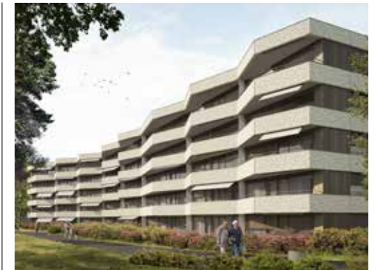
Das im Bau befindliche Projekt Langmoos mit 53 Alters-Mietwohnungen, individuellen bonacasa-Serviceangeboten, einem Mehrzweckraum sowie zwei Dienstleistungsflächen für Spitexdienste ist zwischen dem Wohn- und Pflegezentrum Sonnegg und dem Neubau «Wohnen im Alter» – ebenfalls von bonainvest – eingebettet. Die Wohnungen sind nach bonacasa-Standards ausgestaltet.
